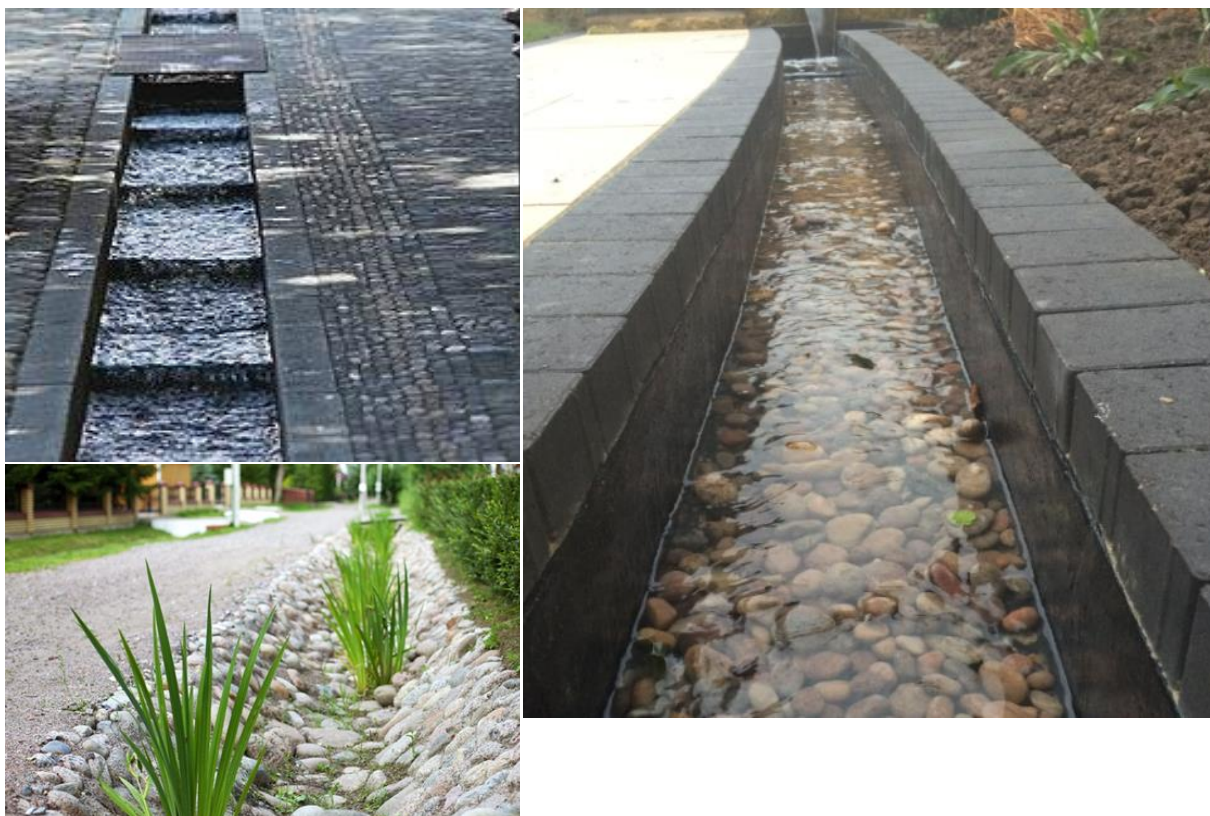
Рисунок 16 – Примеры устройства придорожного канала
