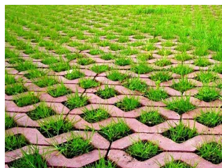
Рисунок 17 – Примеры устройства водопроницаемых покрытий
